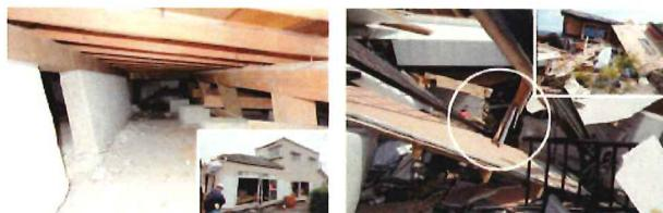
写真3(左) 4(右) 地盤変状が認められ基礎の損傷が顕著な事例(被害形態③)
