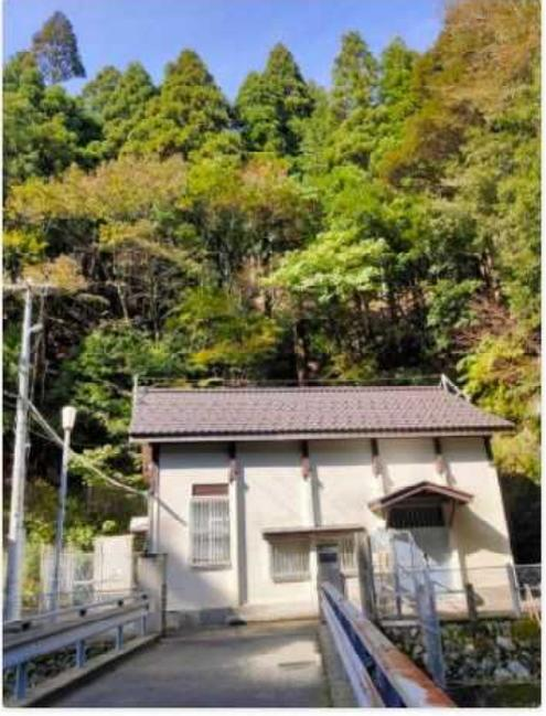
▲関西電力熊川発電所...1919年運用開始、最大出力130kWの小さな水力発電所。現在は河内川ダム湖から水を引き、発電後の水は手前の河内川に流している。疑惑の舞台。福井県若狭町、道の駅熊川
