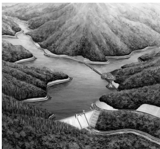
熊川断層から1.5 キロメートル に建設が進められている河内川ダム完成予想図
