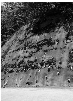
後年、本件直下の工事用道路(ダム完成後に水没)の法面に驚くべき多数のアンカーボルトが打ち込まれていた(写真下)。(次号につづく)
