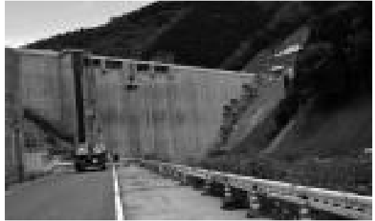
ほぼ完成したダム本体（本年5月10日撮影）
