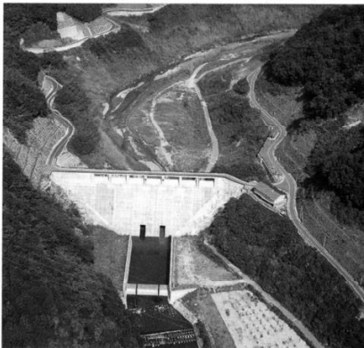
下流より撮影した益田川ダムの全景。河床に近い部分に穴（常用洪水柱2門）がみえていることがわかる（写真提供：島根県）
