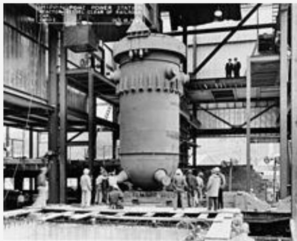
原子炉の本体である圧力容器 (厚さ22cmの鋼鉄の 容器の中に核燃料が 閉じ込められている)
