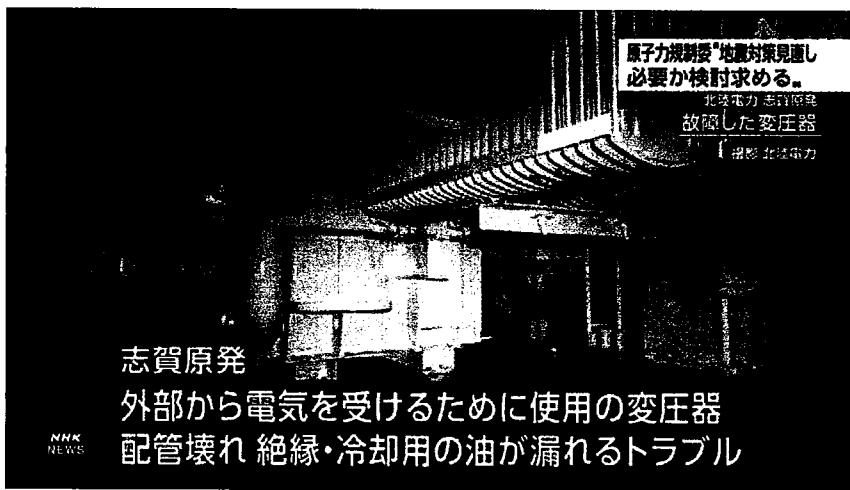
今月1日に震度7の揺れを観測した石川県志賀町にある志賀原発では、震度5弱相当の揺れを観測しましたが、外部から電気を受けるために使われている変圧器で配管が壊れて、絶縁や冷却のための油が漏れるトラブルがあり、現在も外部から電気を受ける系統の一部が使えないくなっています。
