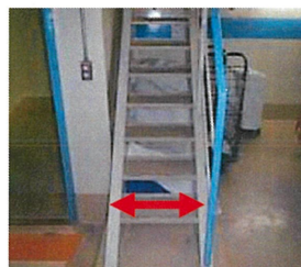
最小階段幅 約0.8m
